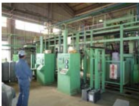
【LPガス容器再検査場(耐圧試験)】
