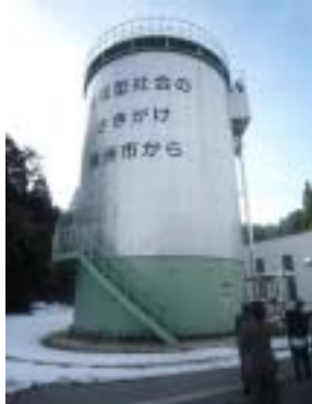
珠洲浄化センター/メタン発酵槽
